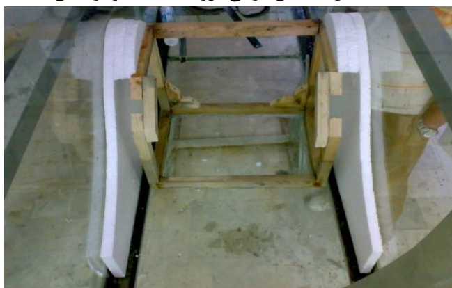
شکل ۲- ساخت بدنهی اصلی نمونه سرریز درون ناوه
