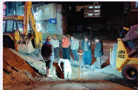
ترمیم شکستگی لوله آب شرب میدان ۲۲ بهمن سقز
