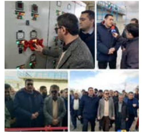
تصفیه خانه فاضلاب روستای قروچای شهرستان دهگلان با اعتبار ۴۸۵ میلیارد ریال و برای
