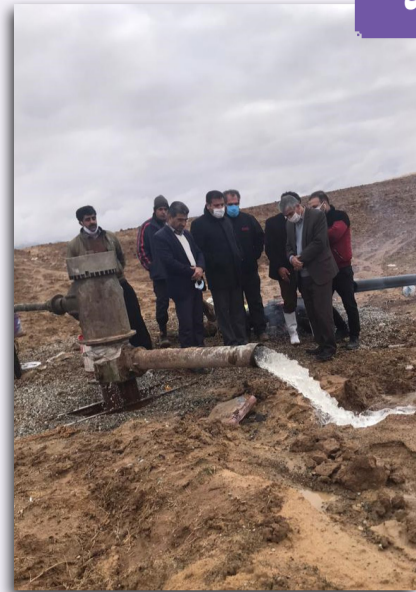
بازدید فرماندار دهگلان و بخشدار بلبان آباد از پروژه آبرسانی به مجتمع گردمیران - بلبان آباد
