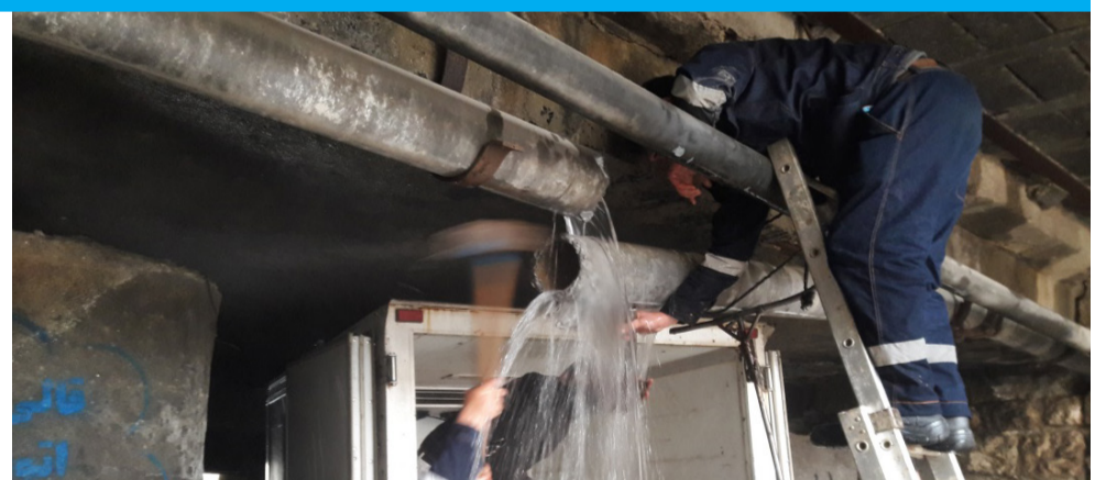
ترمیم شکستگی و لایروبی سرریز فاضلاب بیجار
